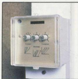
**ATTENTION** : – Lorsque l'on règle la charge d'accumulateurs à l'aide d'un Régéco, il est indispensable de ramener une phase sur la borne (horloge : h) des accumulateurs.
